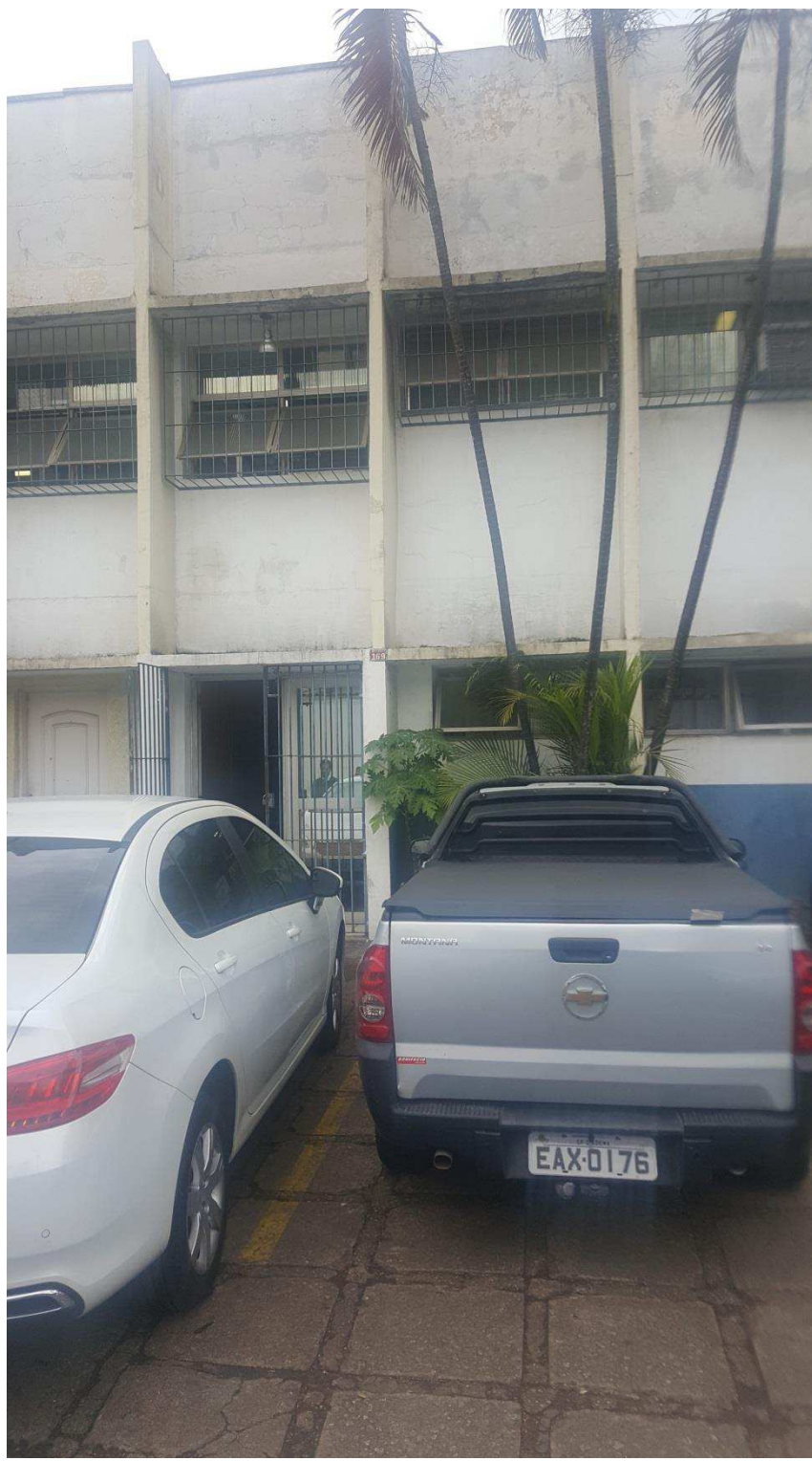
Área externa (visão da rua) - Decon
