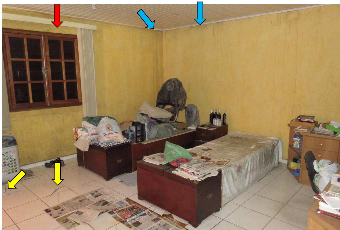
Detalhe das cerâmicas danificadas (setas).
