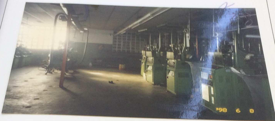
FOTO No. 09 - Vista parcial de um dos compartimentos da edificação No. 1, do imóvel objeto do presente laudo.
