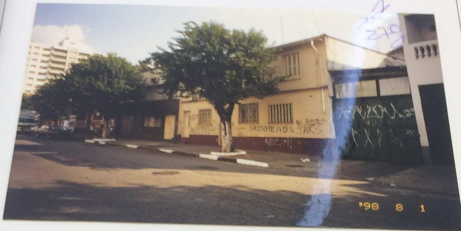
FOTO No. 01 - Vista da fachada da edificação No. 1, do imóvel avaliando a Rua Cipriano Barata
