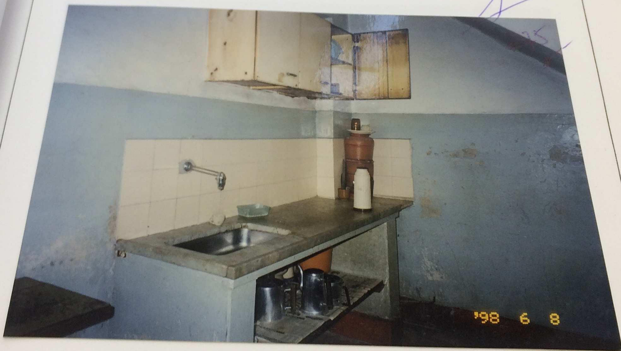
FOTO No. 06 - Vista parcial da copa da edificação No. 1 do imóvel objeto do presente laudo.
