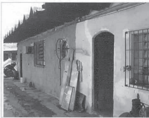
Aspecto geral da edificação
