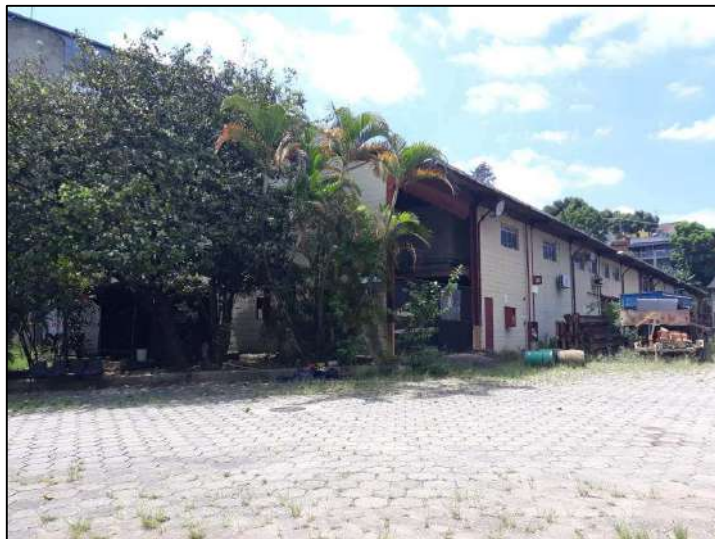
6 FOTO ASPECTO GERAL GALPÃO-ESCRITÓRIOS
