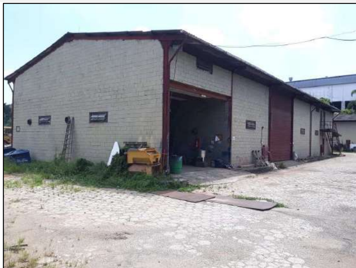
17 FOTO GERAL OFICINA DE PINTURA ALMOXARIFADO
