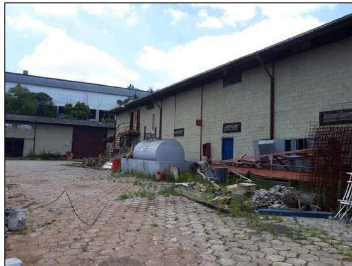
16 FOTO GERAL PATIO-ALMOXARIFADO
