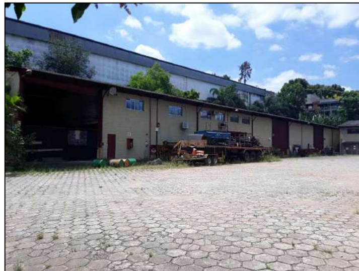
7 FOTO ASPECTO GERAL GALPÃO-ESCRITÓRIOS
