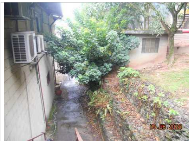
Muro de arrimo – recúo lateral
