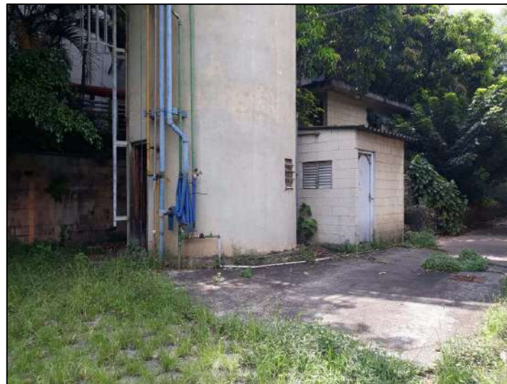
3 FOTO CAIXA DE ÁGUA
