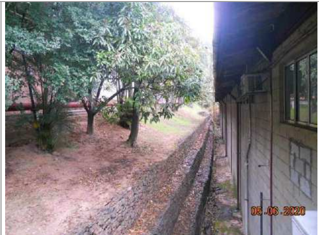
Muro de arrimo – recúo lateral
