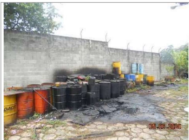
Muro de fechamento
