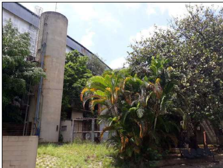
4 FOTO CAIXA DE ÁGUA
