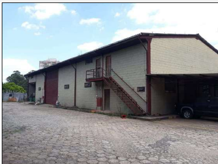
11 FOTO GERAL ALMOXARIFADO
