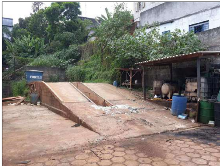
15 FOTO GERAL RAMPA DE LAVAGEM
