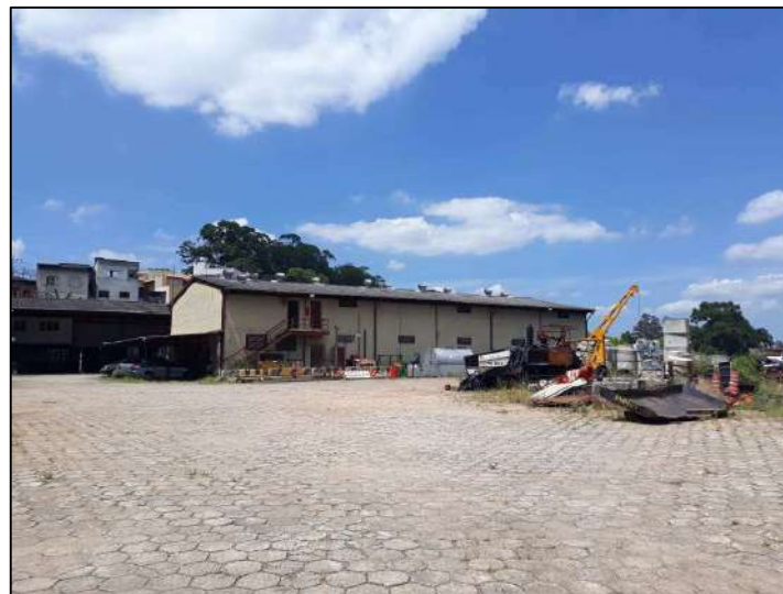
10 FOTO GERAL ALMOXARIFADO
