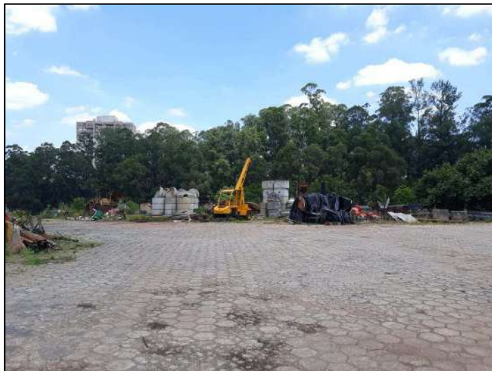
23 VISTA GERAL PATIO DE MANOBRAS
