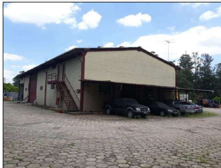
9 FOTO GERAL ALMOXARIFADO
