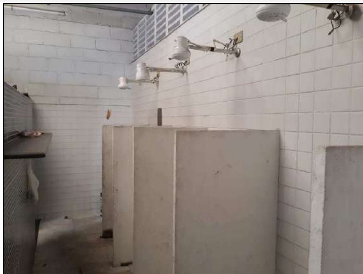
19 FOTO ASPECTO GERAL VESTIARIOS
