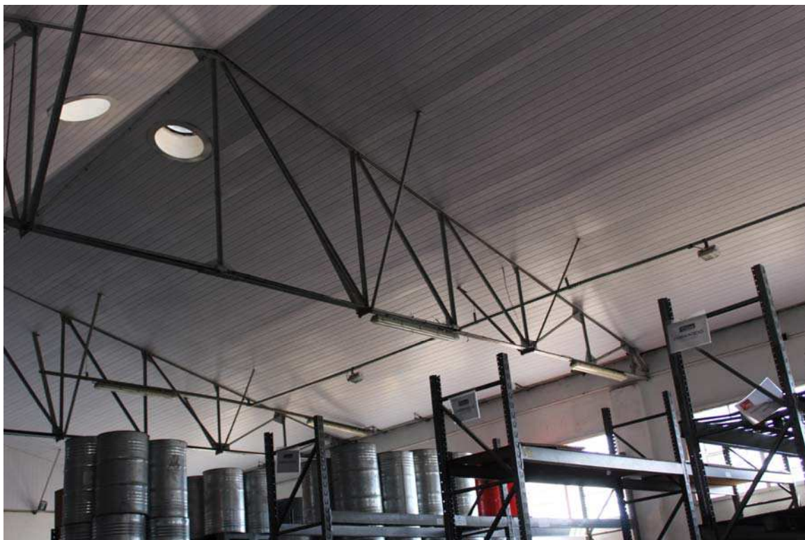
Fotografia 21 – Aspecto interno do galpão 02 e 03.
