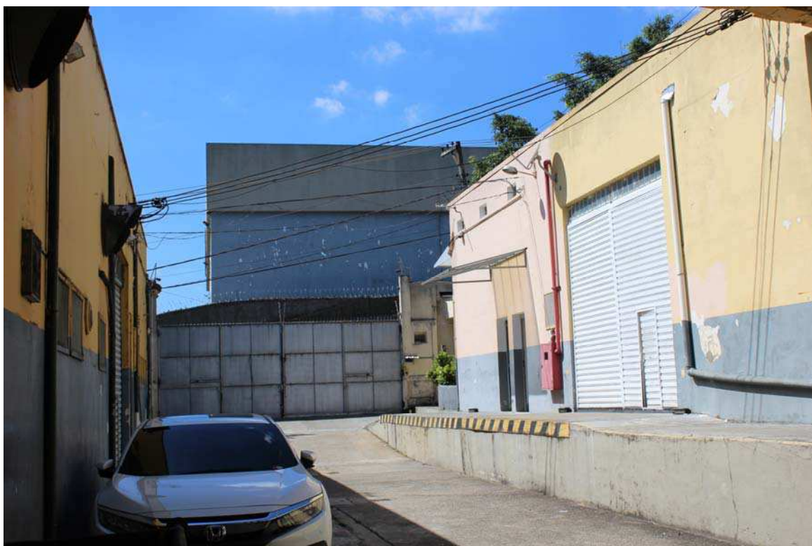
Fotografia 07 – Aspecto interno do imóvel e as construções existentes.
