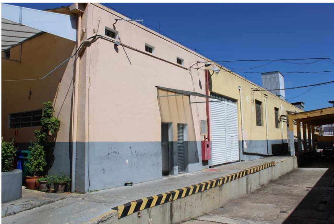
Fotografia 10 – Aspecto interno do imóvel e as construções existentes.
