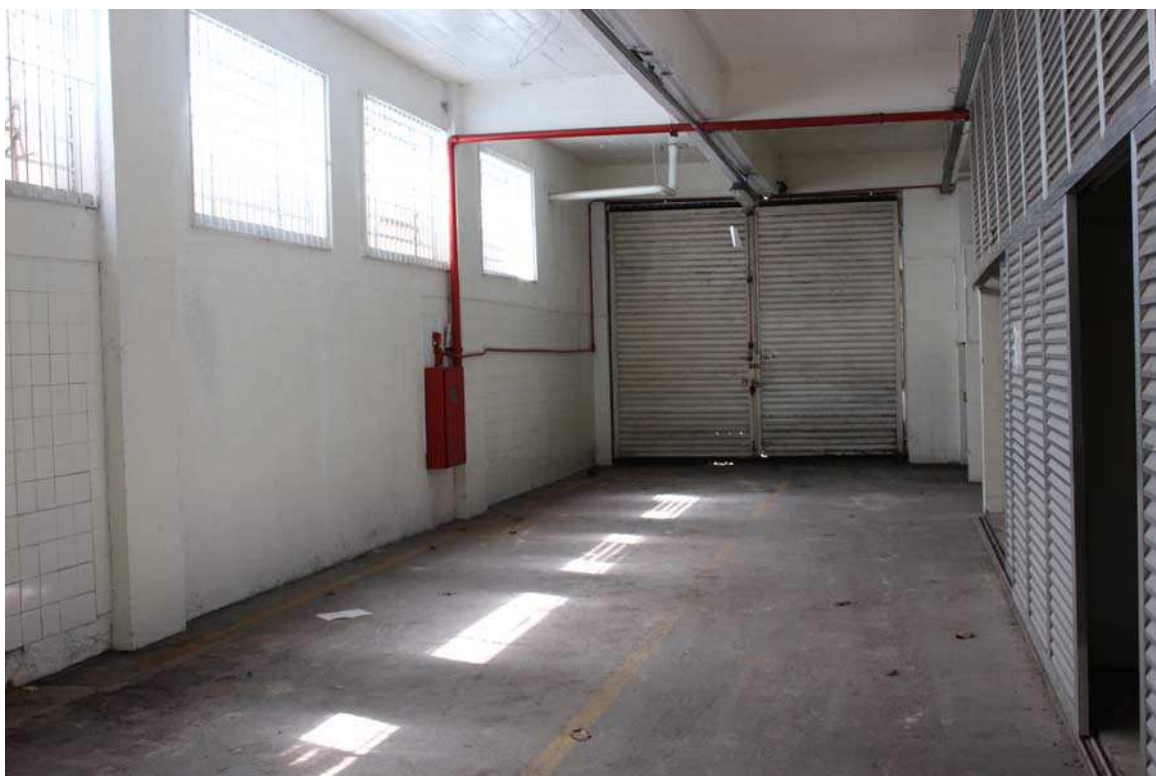
Fotografia 20 – Aspecto interno do galpão 02 e 03.
