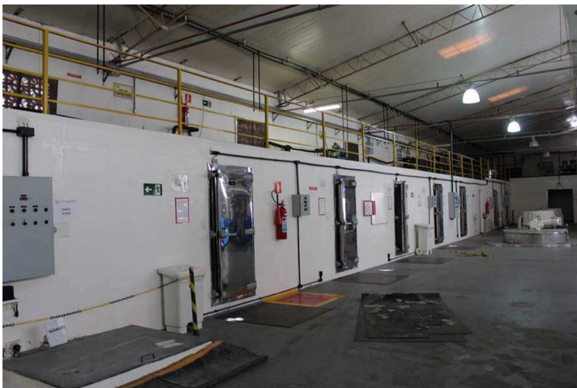
Fotografia 13 – Aspecto interno do galpão 01.
