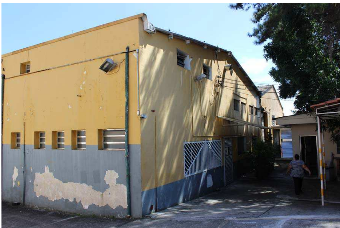
Fotografia 06 – Aspecto interno do imóvel e as construções existentes.
