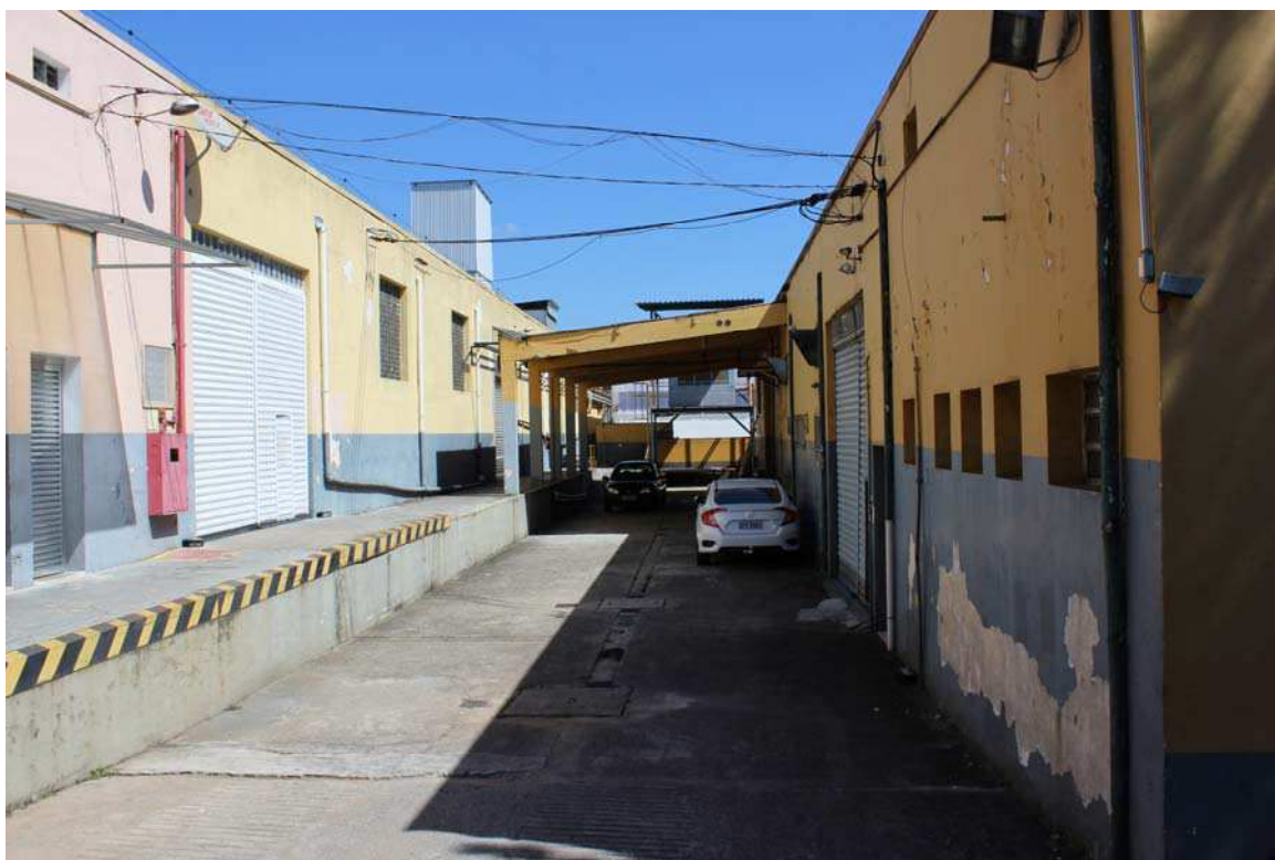
Fotografia 09 – Aspecto interno do imóvel e as construções existentes.
