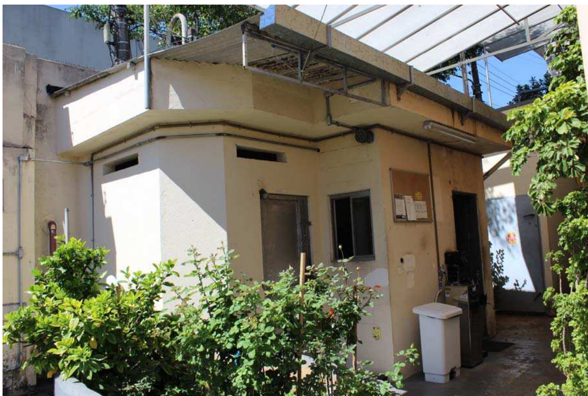
Fotografia 11 – Aspecto interno do imóvel e as construções existentes.
