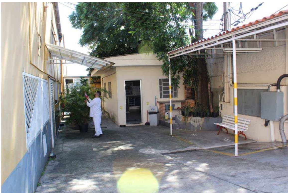
Fotografia 08 – Aspecto interno do imóvel e as construções existentes.
