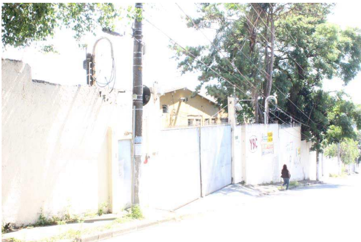
Fotografia 03 – Aspecto do imóvel avaliado junto ao alinhamento da Rua Guarani.
