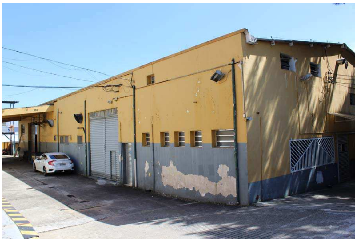
Fotografia 05 – Aspecto interno do imóvel e as construções existentes.
