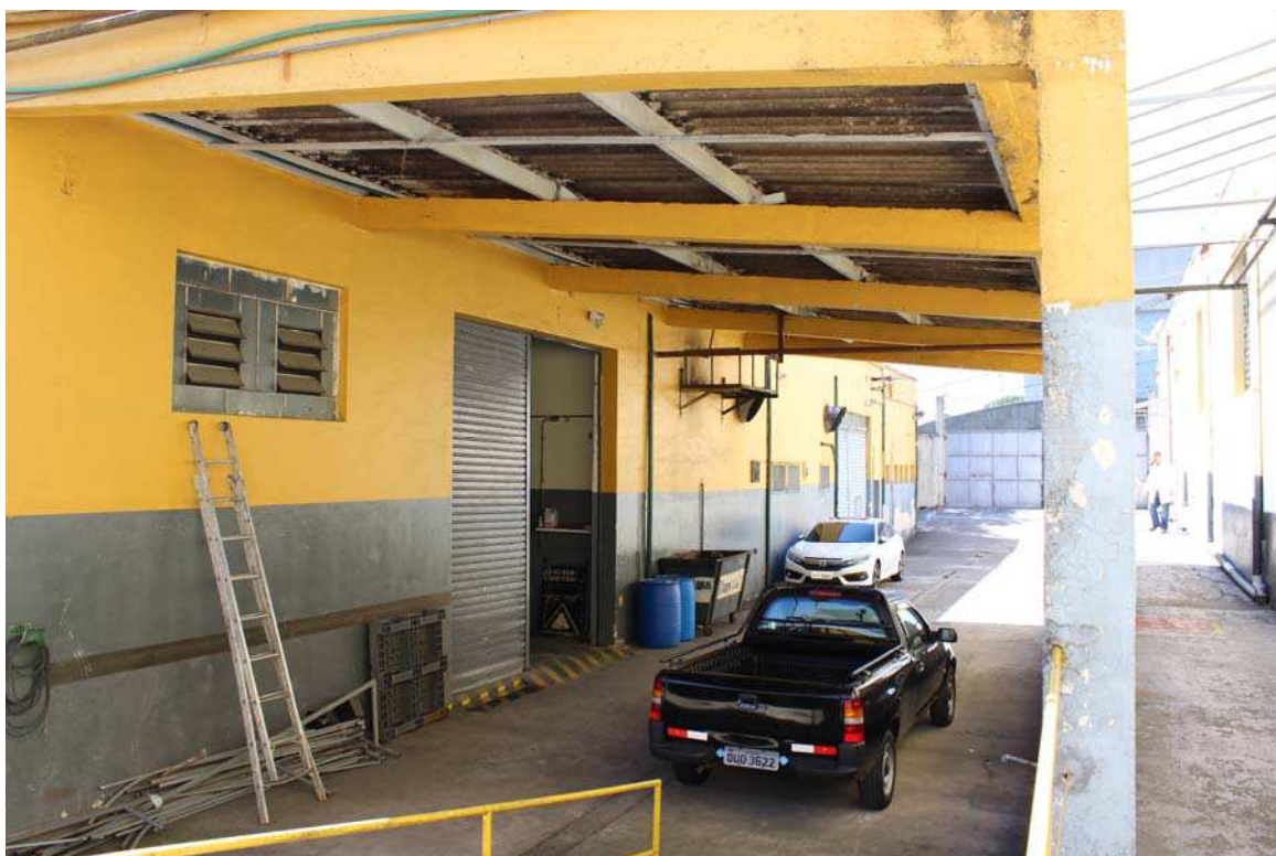
Fotografia 18 – Aspecto externo do galpão 02 e 03.
