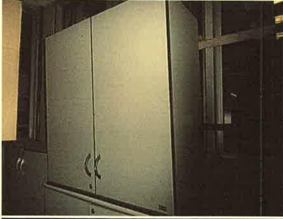
FOTO 114) VISTA DO ARMÁRIO DE MADEIRA. (178)
