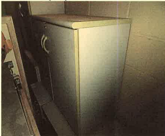
FOTO 111) VISTA DO ARMÁRIO DE MADEIRA. (227)
