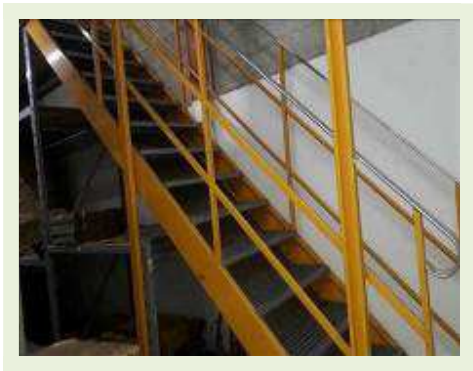
MEZANINO GALPÃO 2 | Item: 128 |
