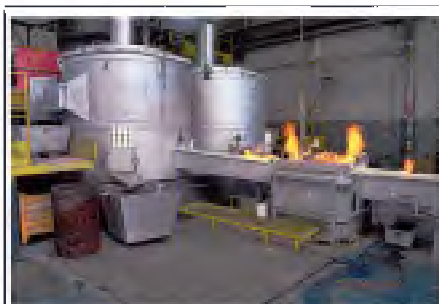
Fornos de aquecimento
