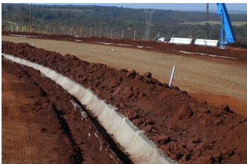
Caneletas de concreto
